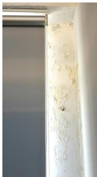
Verifica-se que em algumas paredes do Depósito Central apresentam indícios de infiltração à superfície, com uma grande área de descolamento de tinta, que vai da parede ao tecto.
